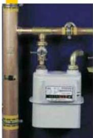
Pour les immeubles collectifs, en aval du branchement, la **conduite d'immeuble** (tuyauterie horizontale) alimente chaque étage en gaz naturel via une ou plusieurs **conduites montantes** (tuyauterie verticale), tiges-cuisines, nourrices de compteurs en local technique, ou encore des branchements particuliers.
