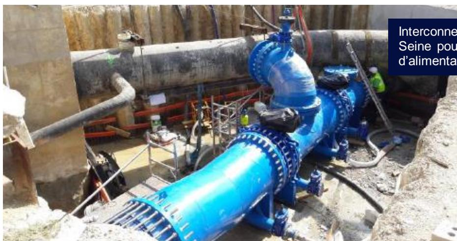
Interconnexion des siphons à Morsang-sur-Seine pour avoir une seconde canalisation d'alimentation en eau potable en secours.
