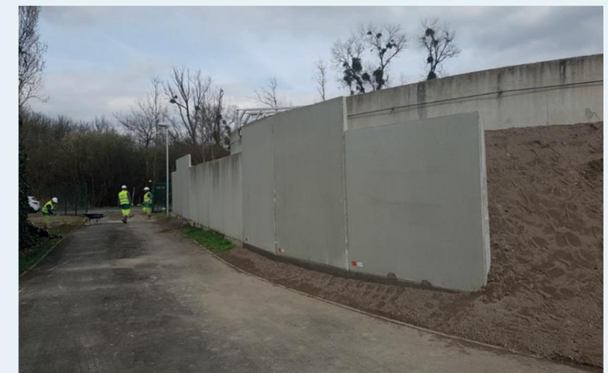
La mise en sécurité du cheminement emprunté pour l'exploitation du bassin de clarification s'est avérée nécessaire. La pose d'un mur béton de soutènement a permis de sécuriser les interven-
