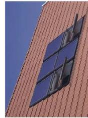
Quatre modules de capteurs thermiques et deux fenêtres de toit constituent un ensemble. © YELLO
