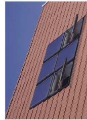
Quatre modules de capteurs thermiques et deux fenêtres de toit constituent un ensemble. Maison individuelle à Vörschnitz (Vielvaux, Autriche) © JELVA
