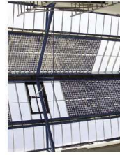
Les capteurs photovoltaïques sont intégrés à la verrière de la galerie de distribution d'une résidence HLM. L'île d'Adonis (Genève) © Pichonnet
