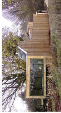
Une conception ouverte à l'énergie solaire permet des formes architecturales innovantes. © Michal Chvala, architecte
