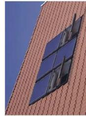
Quatre modules de capteurs thermiques et deux fenêtres de toit constituent un ensemble. © JELVA
