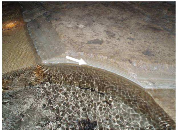
Petit « trottoir » de calcite concrétionné sur le bord d'une cunette d'écoulement (à gauche) et d'un bassin de décantation (à droite).
