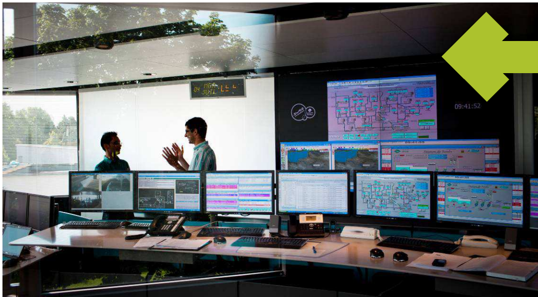
CENTRE DE TÉLÉCONTRÔLE DE MONTGERON
