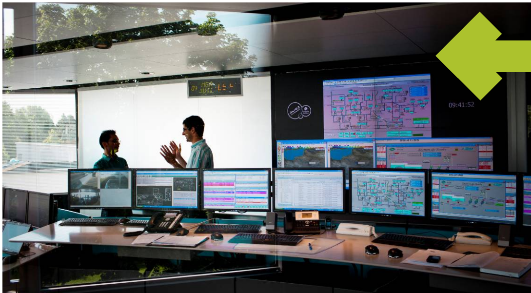
CENTRE DE TÉLÉCONTRÔLE DE MONTGERON
