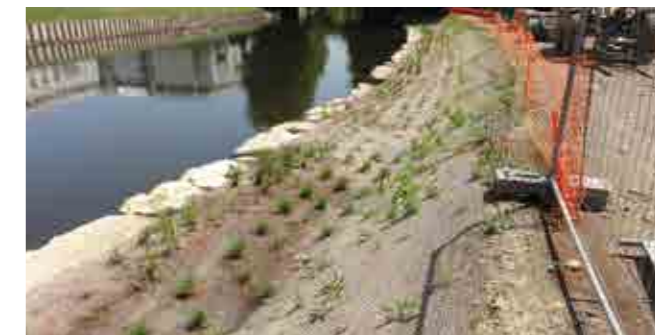
Berges aménagées suite à la 1ère tranche de travaux
