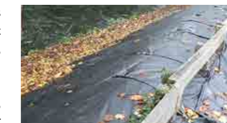
Bâche posée à l'aval du moulin de la Papeterie à Corbeil-Essonnes
