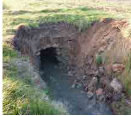
Effondrement de l'ancien ouvrage
