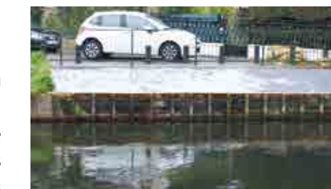
Membrane PVC posée rue du Tir à Corbeil-Essonnes
