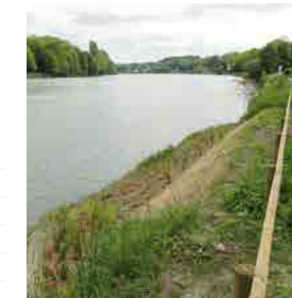
Berges aménagées suite aux travaux d'urgence
