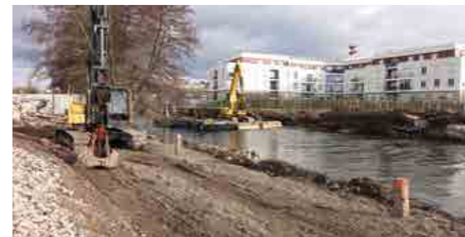
Ancien site papetier pendant les travaux par voie fluviale
