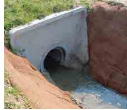
Ouvrage réalisé avec protection des berges
