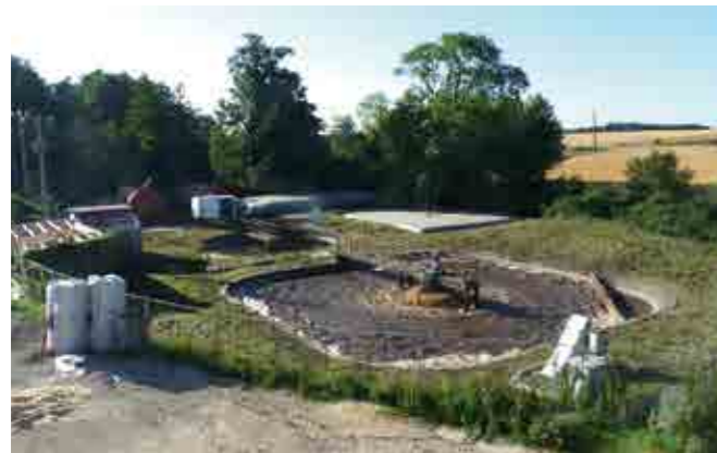
Vue de l'ancienne STEP, Ru de Misery visible en arrière-plan
