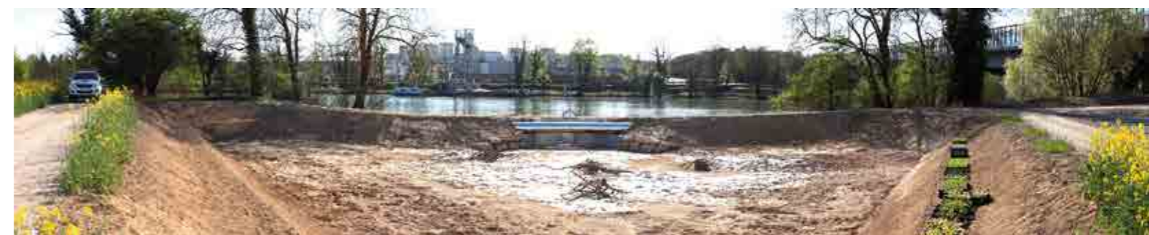
Vue d'ensemble de la frayère aménagée
