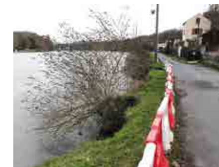
Berges, avant travaux, mettant en péril les biens et les personnes sur la Rive. Intervention par barge depuis la Seine
