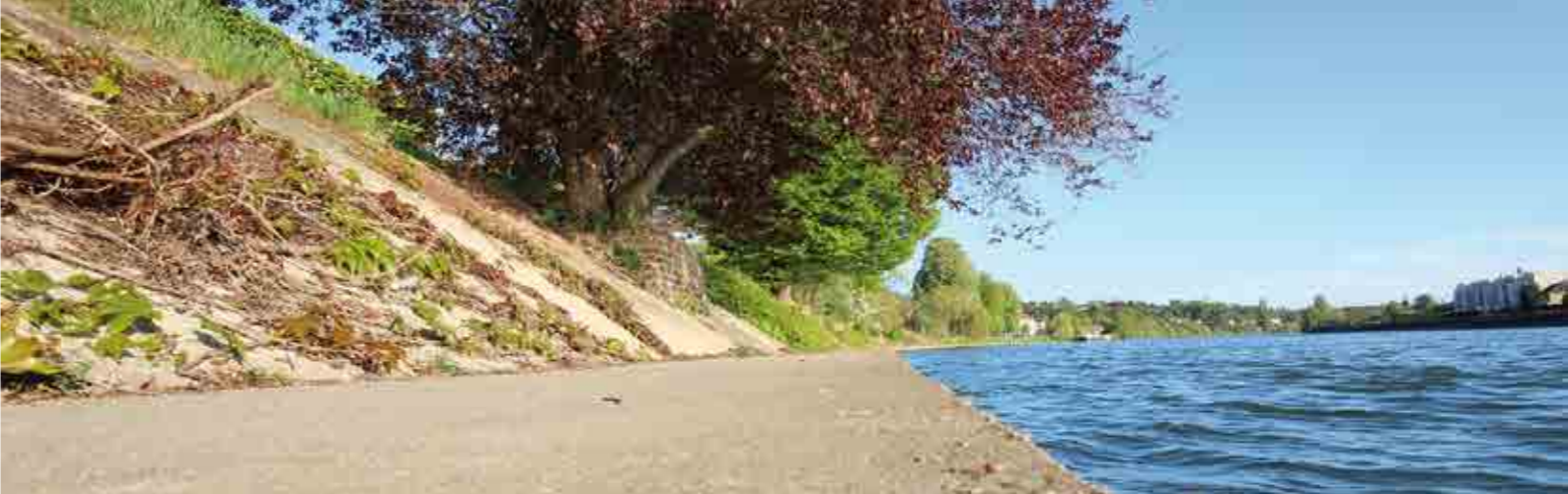
Berges de Seine à Corbeil-Essonnes
