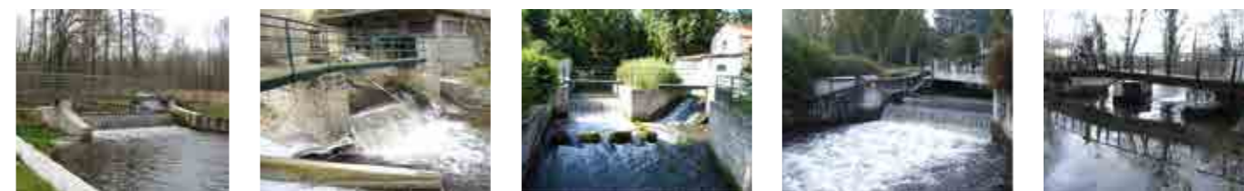
De gauche à droite : barrage Trousseau, moulins de Saint-Eloi, Neuf, Grande Roue et Boutigny
